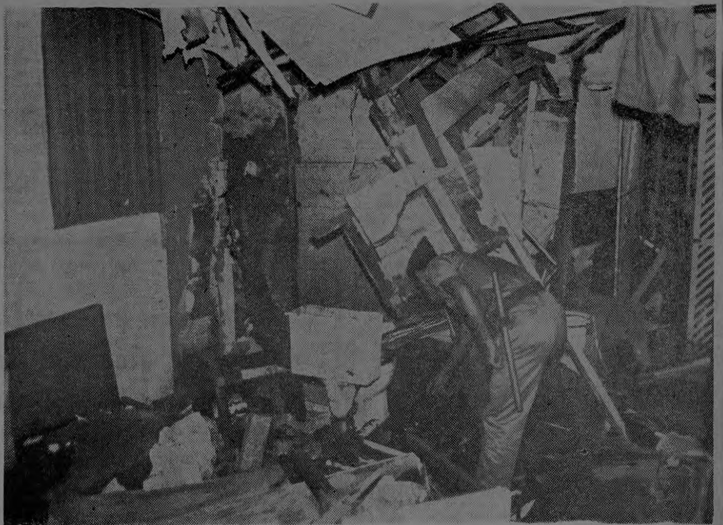
El cabo Rafael Angel Mora Valverde de la Primera Compañía de la Guardia Civil señala al fotógrafo Córdoba, de LA PRENSA LIBRE, el lugar donde desconocidos colocaron dos candelas de dinamita, junto al tanque séptico del Restaurante
